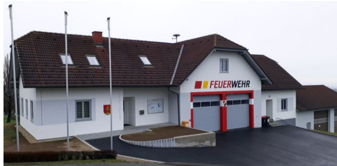
Das Gemeinde- und Feuerwehrhaus nach der Sanierung
