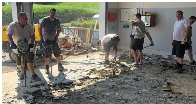
„Floriani’s“ beim Entfernen des alten Bodens im Feuerwehrhaus
